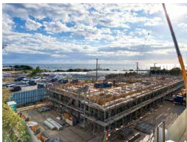
▲ 和歌山工業高専寄宿舍3号館新営その他工事 (御坊市)
