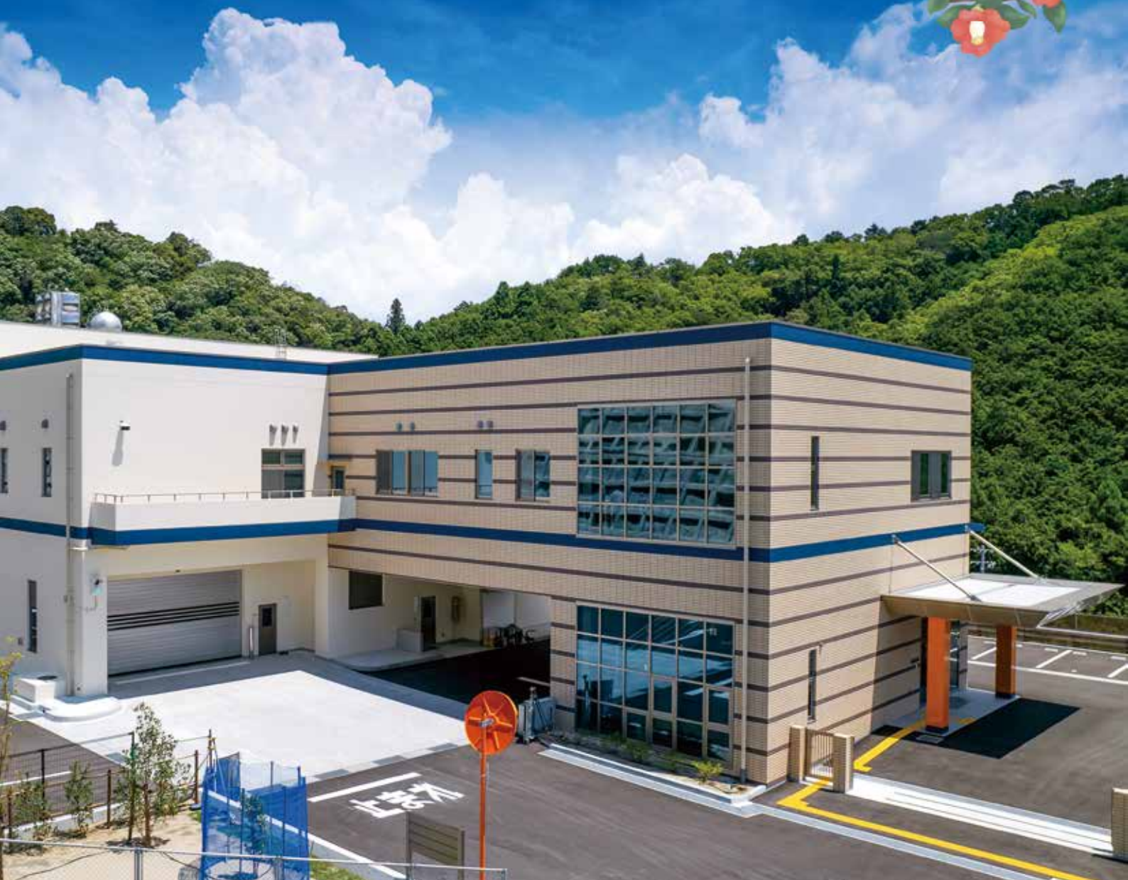
汚泥再生処理施設建設工事(有田郡【元請会社：水ingエンジニアリング株式会社】)
