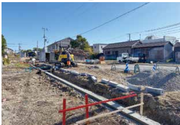
▲ 今福神前線道路改築工事その7 (和歌山市)
