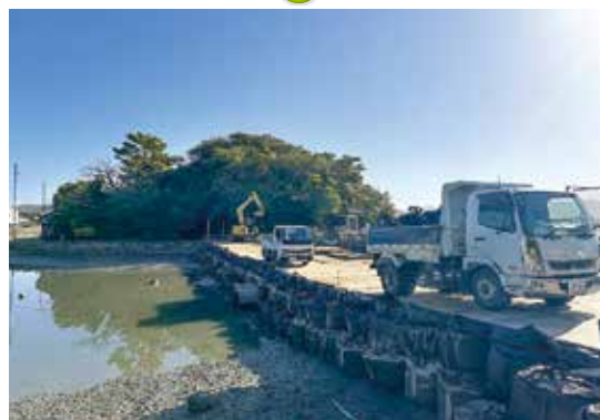
▲ 和歌公園観海閣新築工事 (和歌山市)
