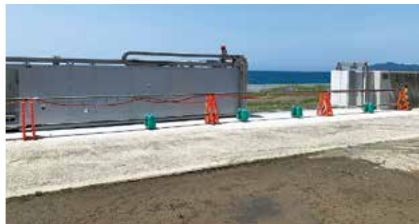
▲ 美浜海岸整備工事 (和歌山県)
